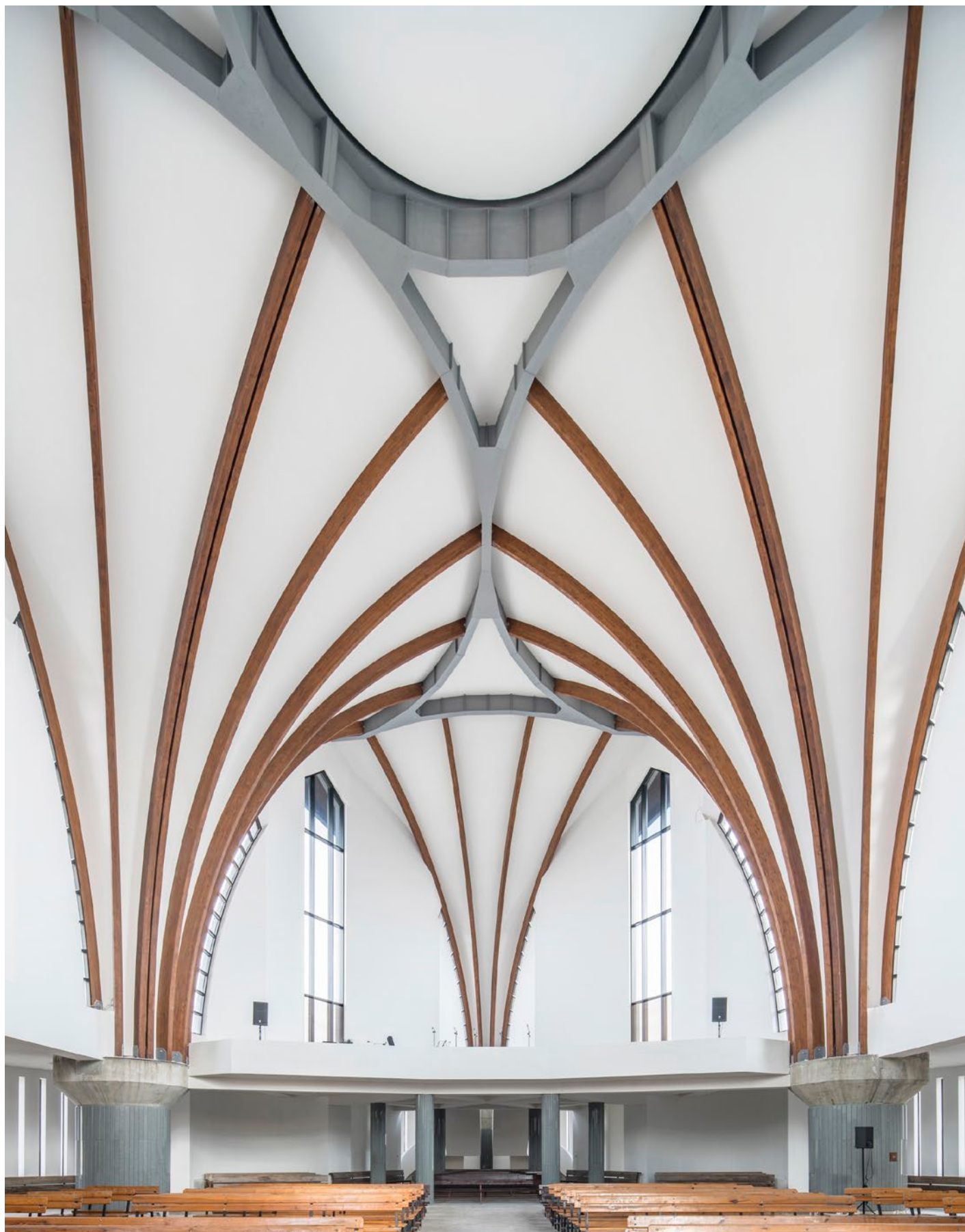
Projekt: Rzymskokatolicka fara, Toruń, Polska Montaż: ProSystem Krzysztof Dziewulski / Strop: Rockfon® Mono® Acoustic
